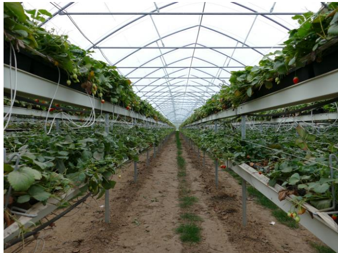
Abb. 1: Foliengewächshaus mit einer speziellen Stellagenkonstruktion auf zwei Ebenen
